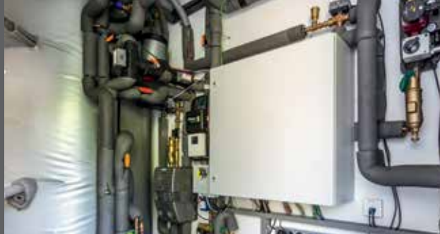
1000 litran puskurisäiliön (vasemmalla) lisäksi järjestelmäkomponentit sijoitettiin niin lähelle toisiaan kuin mahdollista.
